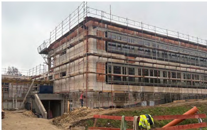
Der Südtrakt des Schulkomplexes mit bereits neu eingebauten Fenstern
